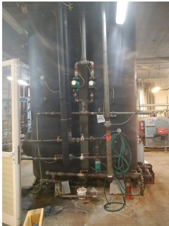
Εικόνα 8: Θερμοδοχεία αποθήκευσης ΖΝΧ
