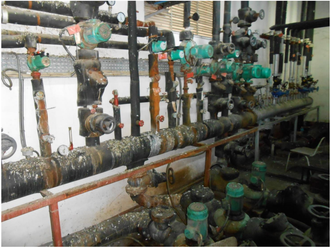
Εικόνα 2: Κεντρικός Συλλέκτης Διανομής - Λεβητοστάσιο
