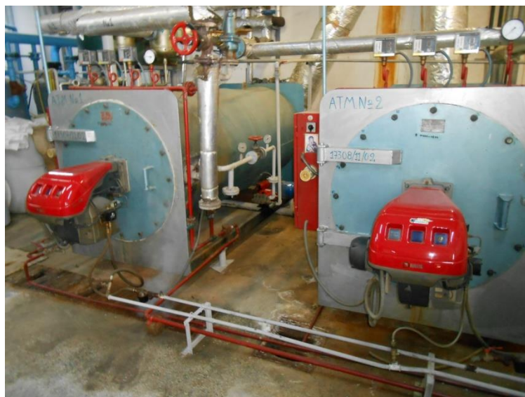
Εικόνα 9: Ατμογεννήτριες της Γενικής Μηχανολογικής Βιομηχανίας με καταναλώσεις στα πλυντήρια, μαγειρεία και το σιδερωτήριο.
